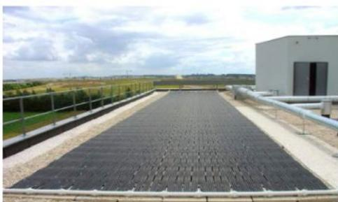
Pose sur blocs béton : le capteur est fixé sur des rangées de blocs béton (ex. : parpaings) par des clips spécifiques fournis avec le capteur.
