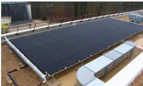
Pose sur châssis : le capteur est fixé sur un support métallique.
