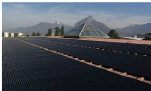
Le capteur Solerpool® peut être posé et fixé directement sur une couverture métallique lorsque le profil d'onde le permet.
