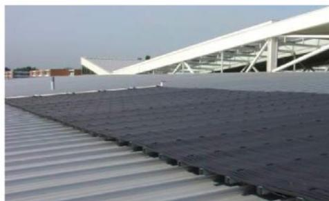
Le châssis métallique permet la pose sur une toiture inclinée.
