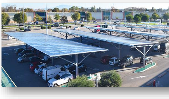
exemple d'ombrières de parking (Source Helexia)
